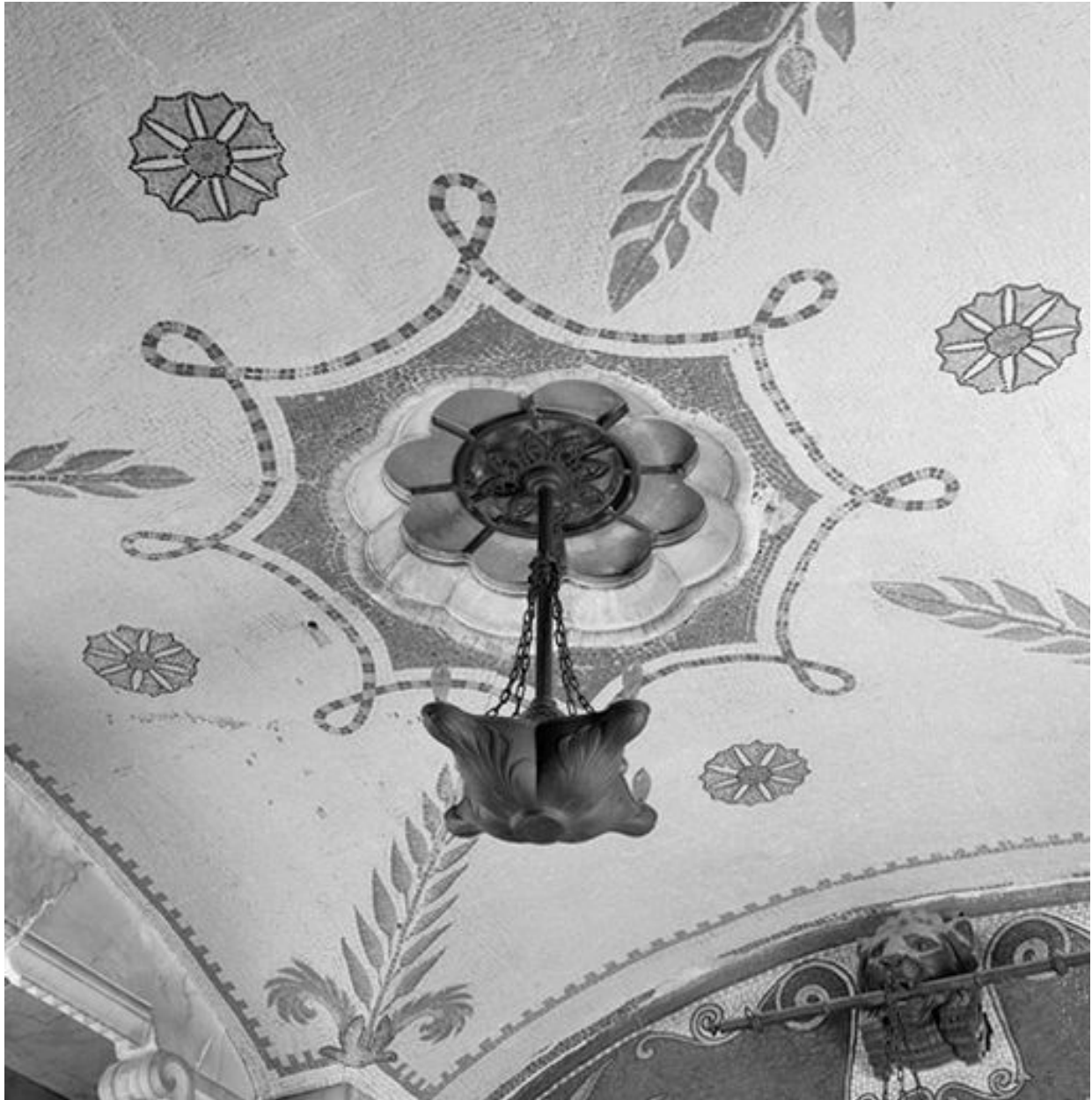
Voûte de la travée I
